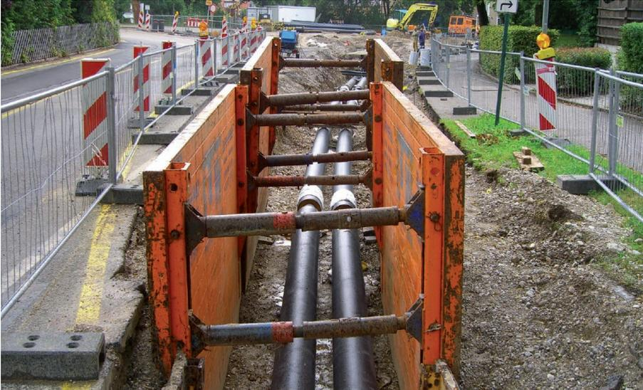
Anfang April werden die ersten Rohre für das Wärmenetz verlegt.
