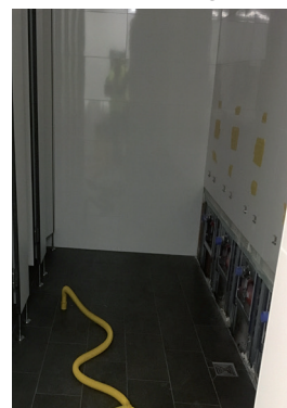
Einzelne Bohrlöcher in den Toiletten
