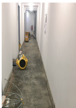
Trocknungsgertäte im Dauereinsatz
