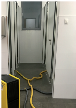
Auch in den Toiletten wird gearbeitet
