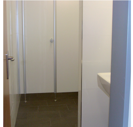
Die sanierten Toiletten
