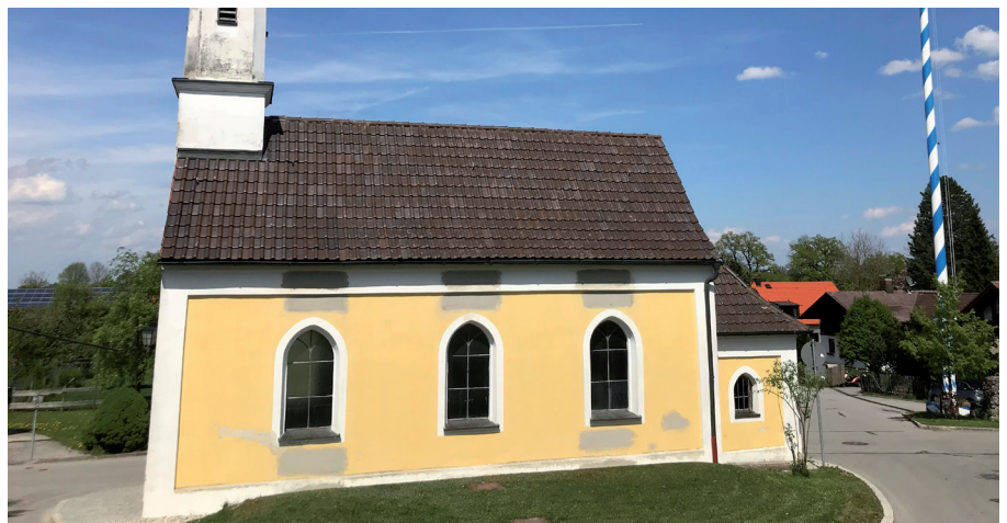
St. Anna - das Mauerwerk ist nun saniert - bald wird die Kirche gestrichen
