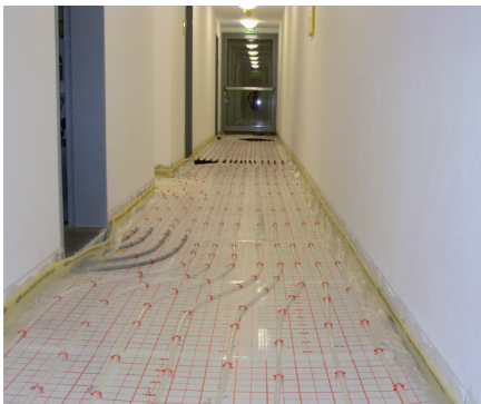
Verlegung der Fußbodenheizung ist abgeschlossen
