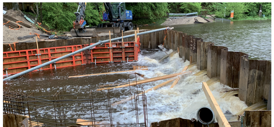
Für die Sanierungsarbeiten am Deininger Weiher wurden diese Spundwände aufgestellt
