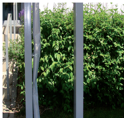
Beschädigte Fallrohre
