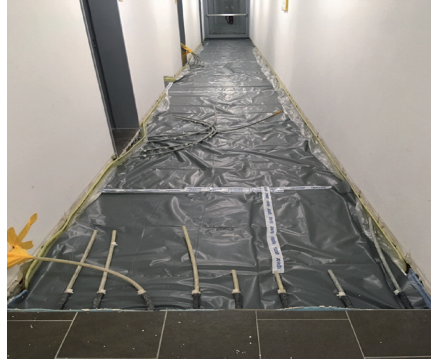
Dämmung und Abdichtung sind verlegt
