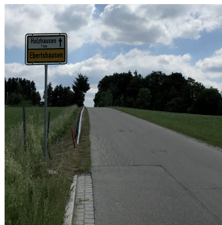
Ein Teilstück der geplanten Sanierung
