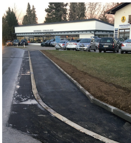
Der neue Gehweg an der Tölzer Straße
