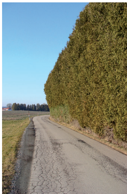
Gleißentalstraße - marode Straße mit schlechter Sicht durch auskragende Thuje
