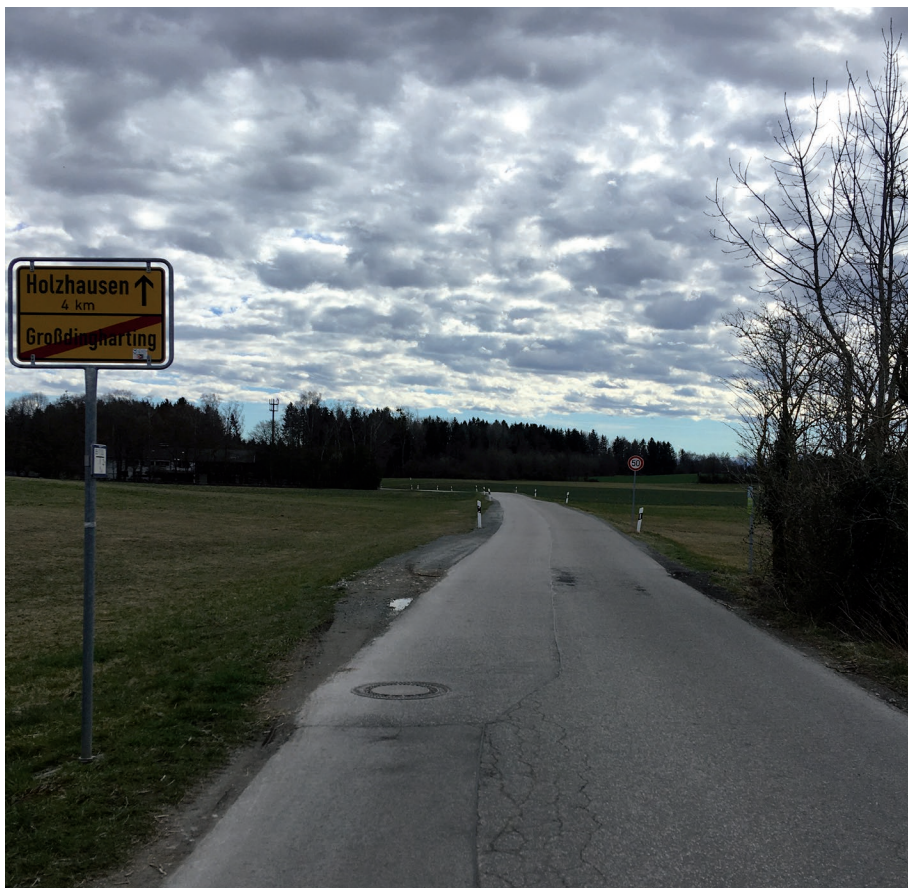
Gleißentalstraße wird ab dem Ortsschild bis zum Mobilfunkmasten ausgebaut
