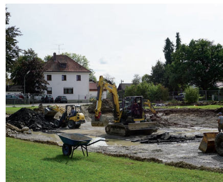
Von Tag zu Tag sieht man den Fortschritt der Bauarbeiten
