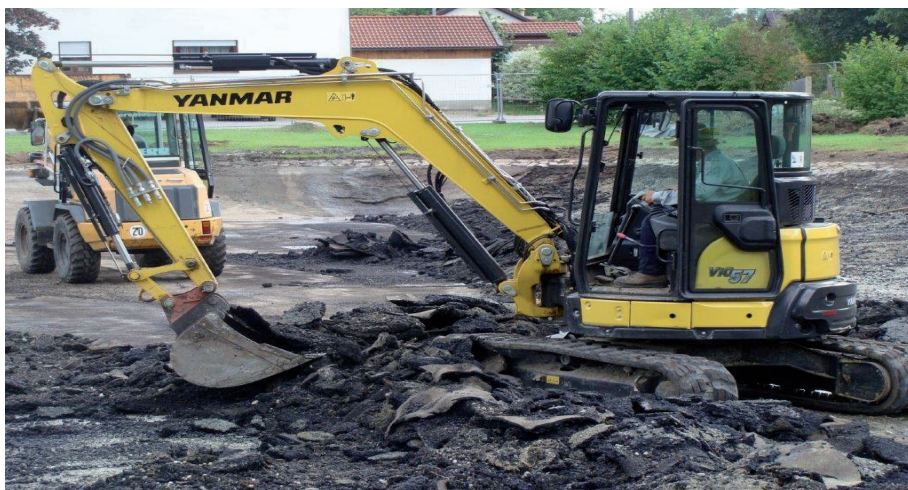
Die Fische wurden umgesiedelt, der Schlamm abgepumpt und der Teer aufgebrochen und entsorgt.
