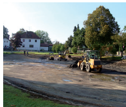
Mit schwerem Gerät, aber auch viel Handarbeit wird Schicht für Schicht abgetragen
