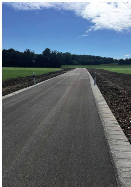
Die neue Gleißentalstraße in Großdingharting ist fertig gestellt.
