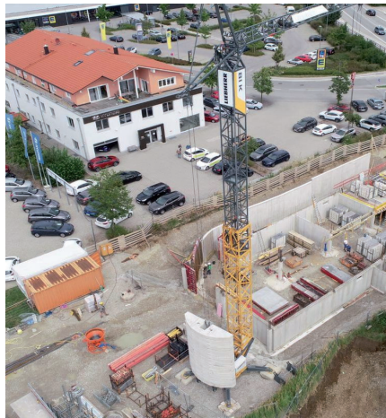
Blick auf die Baustelle im Gewerbegebiet
