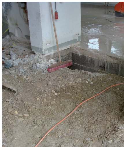
Baufortschritte sieht man fast täglich - nun muss der Boden aushärten
