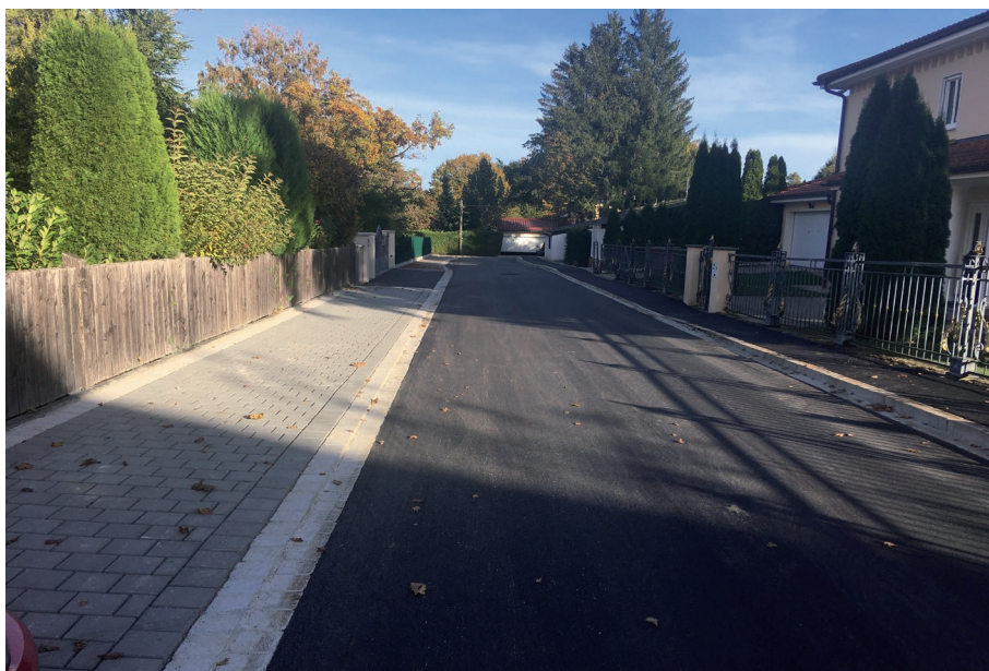
Die Föhrenstraße in Hailafing ist ebenfalls abgeschlossen
