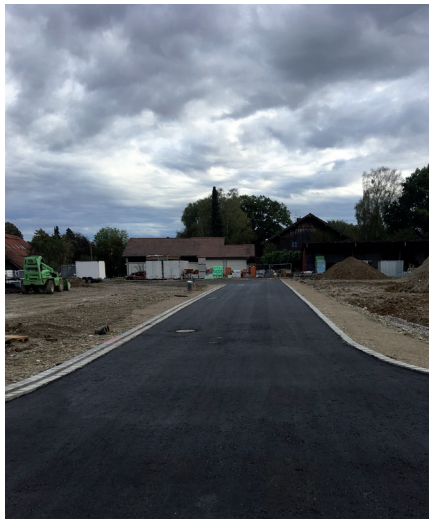
Die Straße Beim Pfleger in Strasslach ist fertig gestellt
