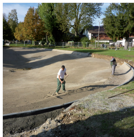
Viel Handarbeit ist an der Baustelle ebenfalls gefragt.
