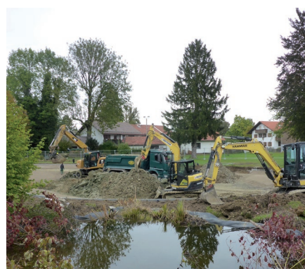
Im Vordergrund ist das Ersatzgewässer zu sehen. Es wurde angelegt, damit Molche, Libellenlarven, Schnecken und weitere Wassertiere die Bauphase gut überstehen.
