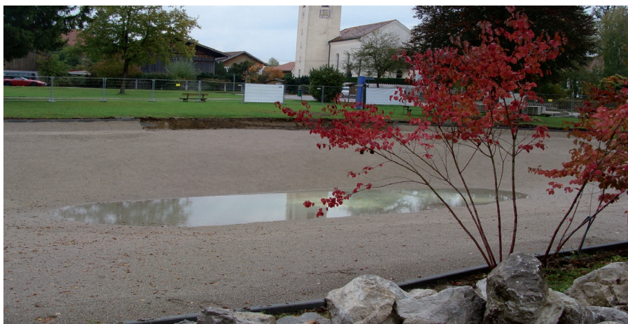
Der Weiher ist für die Verlegung der Folie fertig präpariert.
