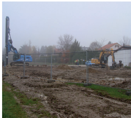
Die Bagger sind bereits angerollt.
