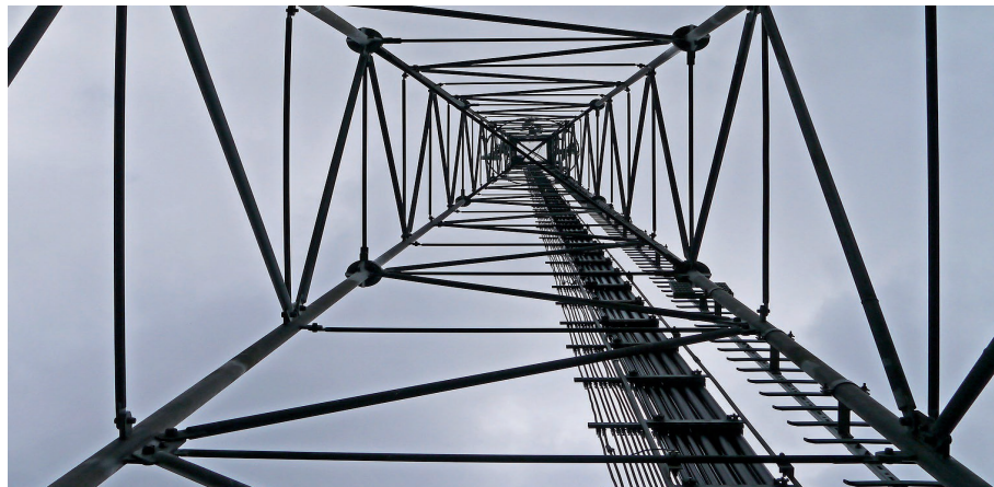
Beispielbild eine Mobilfunkmasten in Leichtbauweise
