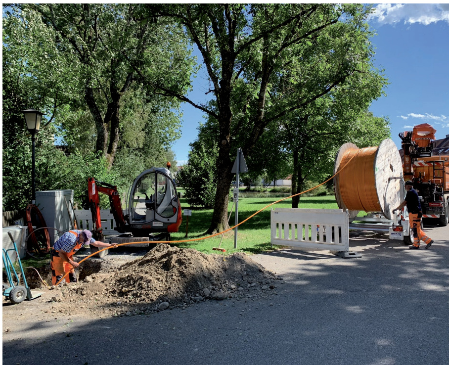
Die Bauarbeiten für den Glasfaseranschluss für die Grundschule in Straßlach fanden bereits im Sommer 2019 statt
