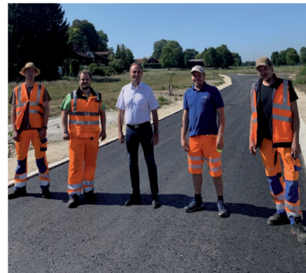
Die neue Straße im Talfeld-Nord „Pfarrer-Kohlhauf-Straße“ ist fertiggestellt.
