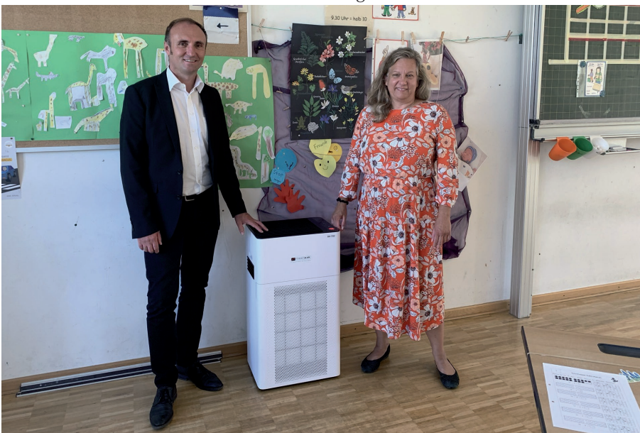
Bürgermeister Hans Sienerth und Rektorin Susanne Kirchhof freuen sich über die rechtzeitige Inbetriebnahme der Lüftungsgeräte in allen Klassen der Grundschule.
