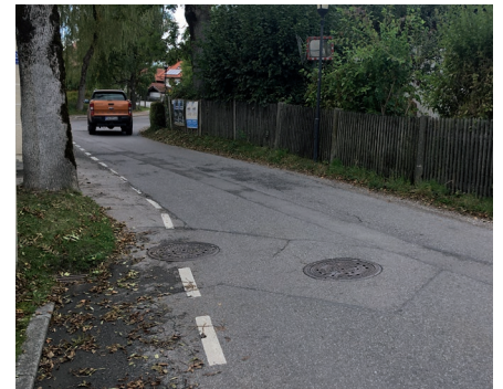
Ein neuer Schutzstreifen soll Fußgängern und Radfahrern mehr Sicherheit verschaffen.
