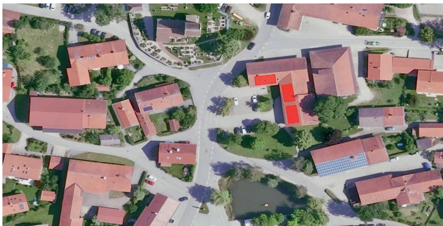
Photovoltaik ja, am besten so, dass die Gebäude sich selbst mit Strom versorgen können.
