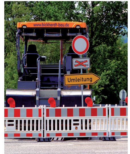
Ab Mitte Mai ist die Ortsdurchfahrt Deining bis Ende 2023 gesperrt.
