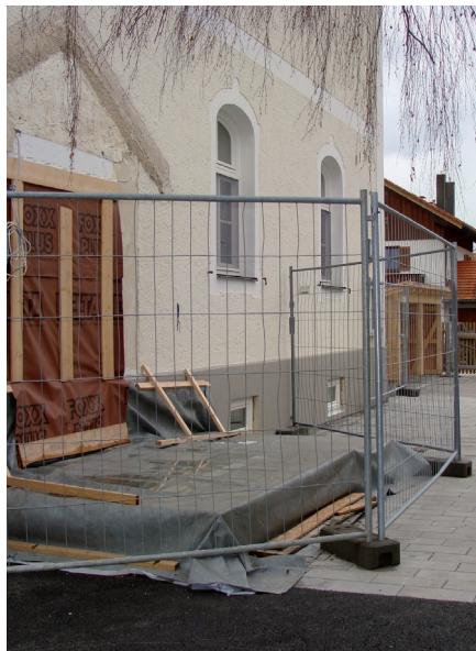
Die Handwerker sind bereit, doch Petrus lässt die Baumaßnahmen stocken.
