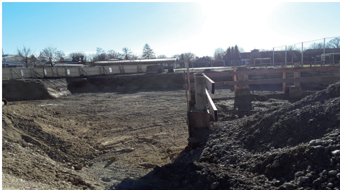
Erdaushub fertig Dezember 2020
