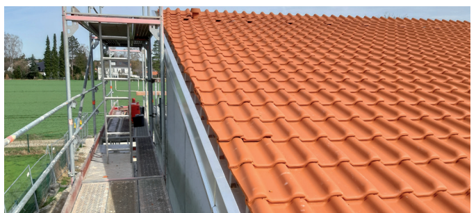
Richtfest und Dacheindeckung April 2022
