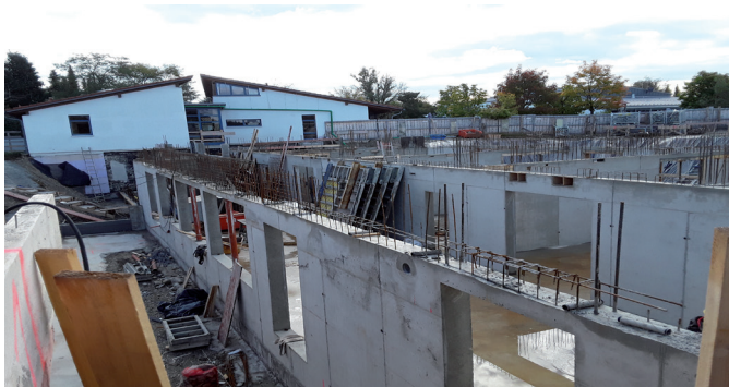
Anschluss Altbau KG September 2021
