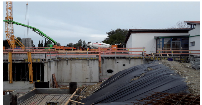
Schalung Wände KG Oktober 2021
