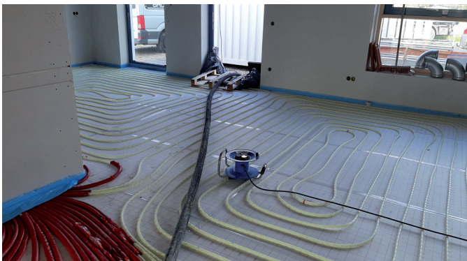
Verlegung Estrich u. Fußbodenheizung Oktober 2022
