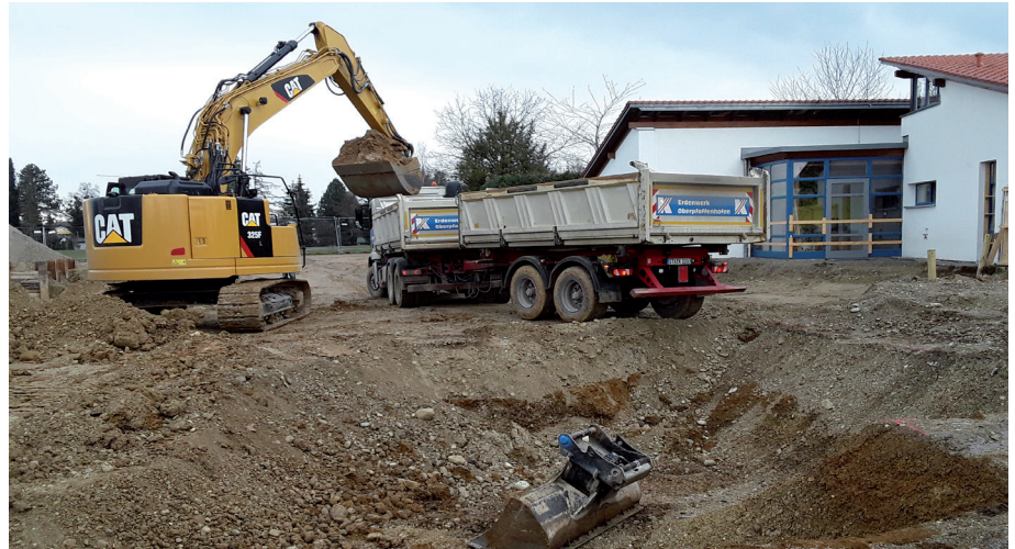
Verbau Erdarbeiten Dezember 2020
