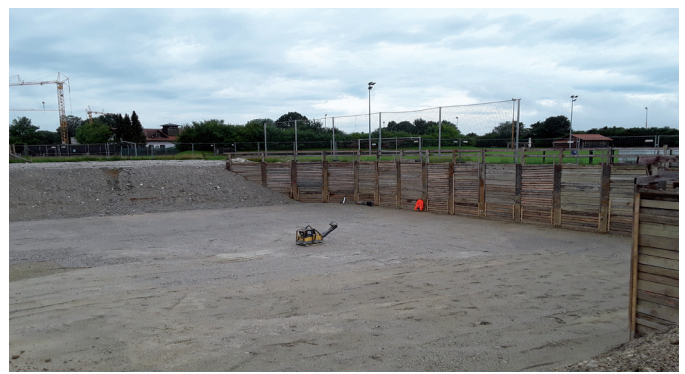
Baugrubenaushub Fertigstellung Juli 2021
