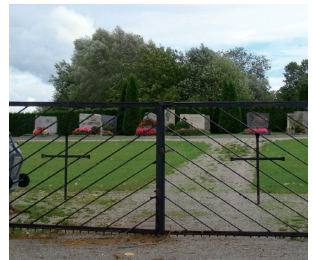
Die Tore am Friedhof Dingharting sind leider nicht mehr reparierbar und sollen durch neue ersetzt werden.
