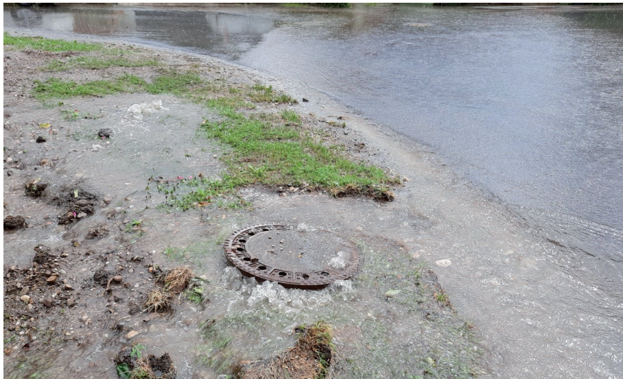
Eine gewaltige finanzielle Kraftanstrengung ist nötig, um die Überschwemmungen in der Deisenhofner Straße nach dem Kreisverkehr gemeindeauswärts in den Griff zu bekommen.
