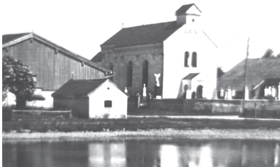
Das erste Feuerhaus am Weiher in Strasslach. Gemeint ist das kleine Gebäude im Vordergrund.
