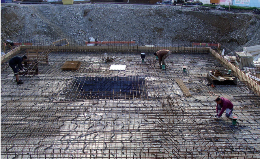
Die Baufirma arbeitet an der Bodenplatte. In der Mitte gut zu sehen das Schachtbauwerk für den Aufzug. Alle Wohnungen werden barrierefrei und sollen auch barrierefrei erreichbar sein.
