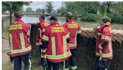
Sandsackverstärkter Deich wird besichtigt.
