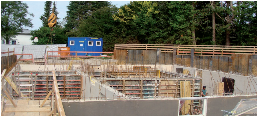
Der Bau des Mehrfamilienhauses in der Ortsmitte kommt gut voran. Entgegen einiger Entwicklungen in der Baubranche sind wir gut in der Zeit und die Kosten bewegen sich stabil im vorgegebenen Rahmen.
