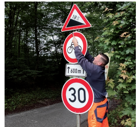
Anfang Juli montierte ein Mitarbeiter des Bauhofes das Verkehrszeichen ab. Wir hoffen, dass es zu keinen weiteren Unfällen an der Hangstraße kommt.
