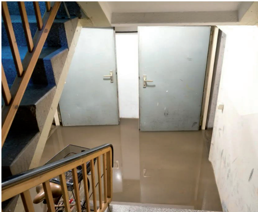
Ein überfluteter Keller nach einem Starkregenereignis stellt alle Betroffenen vor Herausforderungen.
