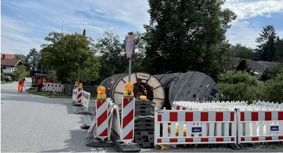
Die Verlegung der Glasfaserkabel in Holzhausen hat pünktlich begonnen.
