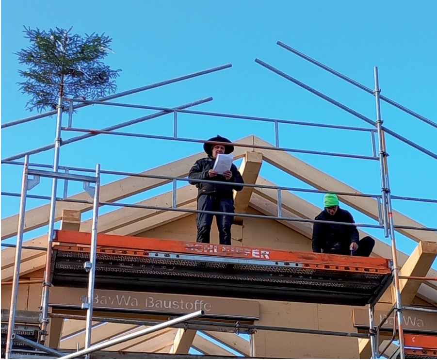
Traditionell vom Dachstuhl herunter: Der Zimmerer Hans Rieger spricht seine Dankes- und Segensverse und sorgt mit viel zerschlagenem Glas für ganz viel Glück.
