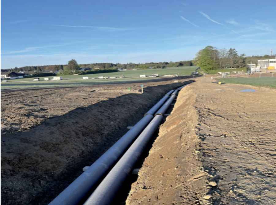
Drei Tiefbaukolonnen haben bereits 4200 m Hauptwärmeleitungen verlegt und verschweißt.
