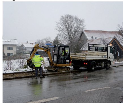
Zuerst musste der beschädigte Belag abgetragen werden.
