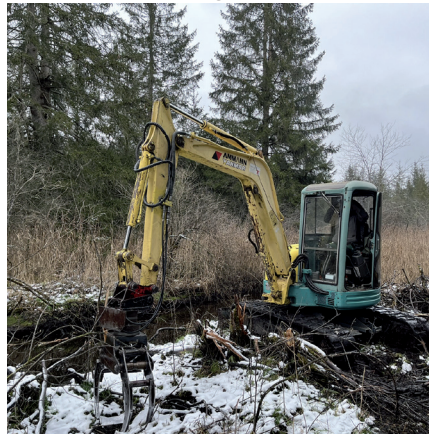
Entnahme des Bewuchses und des Totholzes durch die Firma Grasl
