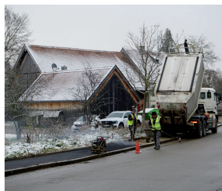
Der neue Bodenbelag sorgt dafür, dass Sie hier ab sofort wieder trittsicher unterwegs sein können.
