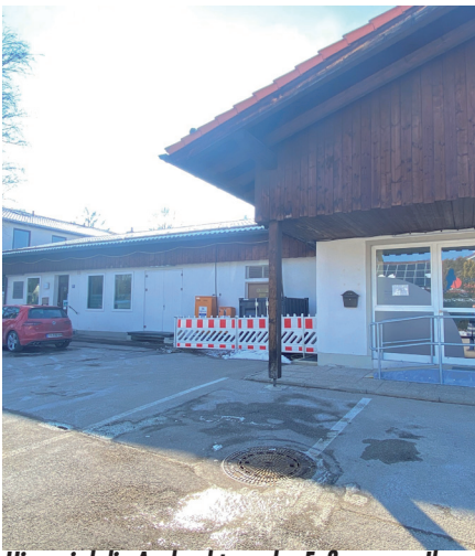
Hier wird die Ausleuchtung der Fußwege zu Ihrer Sicherheit verbessert.
