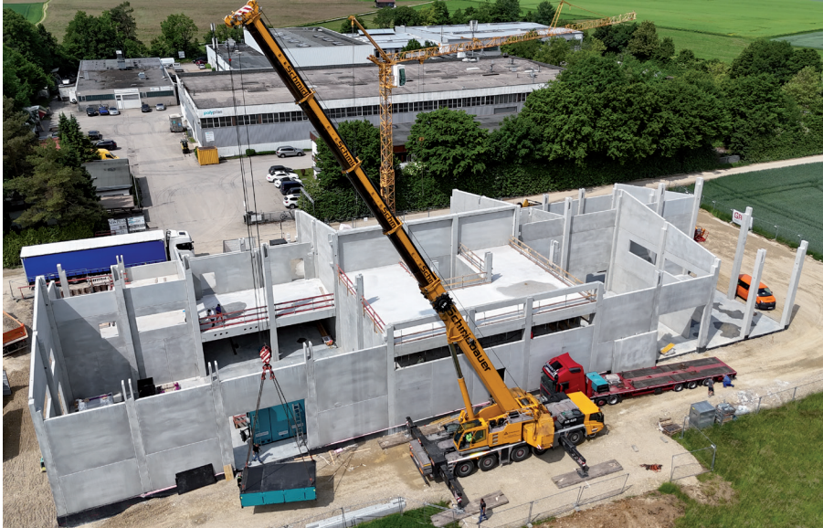
Die Bauarbeiten schreiten zügig voran.
