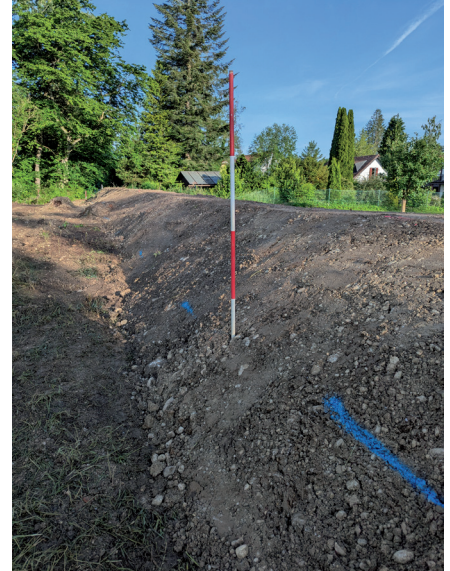
Hailafing: Der Erdwall wird aufgeschüttet.
