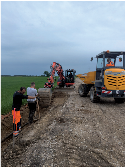
Die Bauarbeiten in Hailafing sind voraussichtlich bis Ende des Monats beendet.
