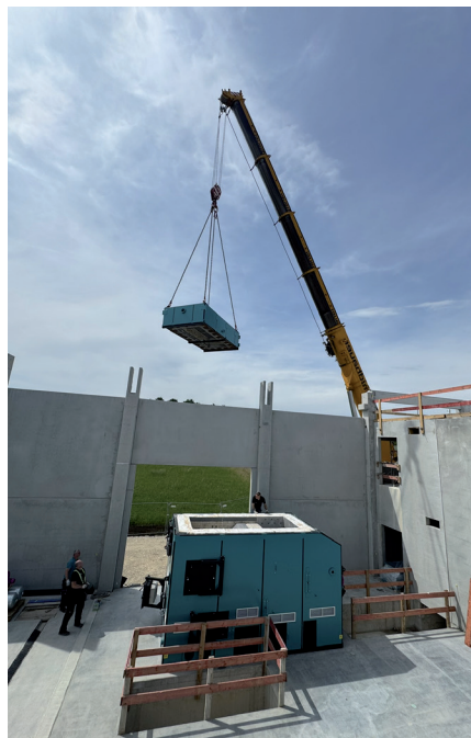
Die Komponenten des Biomassekessels werden mit dem Kran in den Rohbau gehoben.
