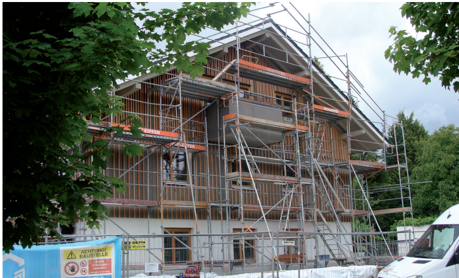
Noch steht am Mehrfamilienhaus das Baugerüst.
