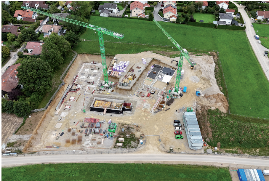
Das Esterholtz Living Resort wächst: Beinahe jeden Tag ist ein Baufortschritt zu sehen. Hier entsteht ein maßgeschneidertes Wohnkonzept, das Seniorinnen und Senioren Komfort und Sicherheit bietet, sich ihren Bedürfnissen anpasst und in dem man selbstbestimmt altern kann.
