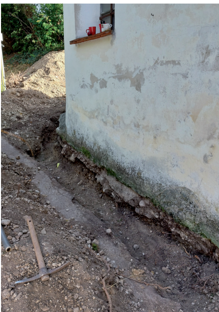
Hier erkennt man den Zustand der Bausubstanz vor den Sanierungsarbeiten.
