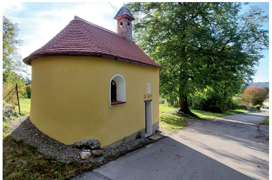
Heute strahlt die Kapelle wieder in ihrem alten Glanz: alle Sanierungsarbeiten wurden unter Aufsicht des Landesamtes für Denkmalschutz mit originalgetreuen Materialien durchgeführt.
