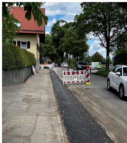
Während der Bauarbeiten regelte eine Baustellen-ampel den Verkehr auf der Tölzer Straße.
