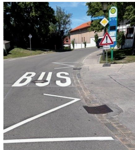
Eine gut sichtbare Markierung erhöht die Sicherheit in Großdingharting.
