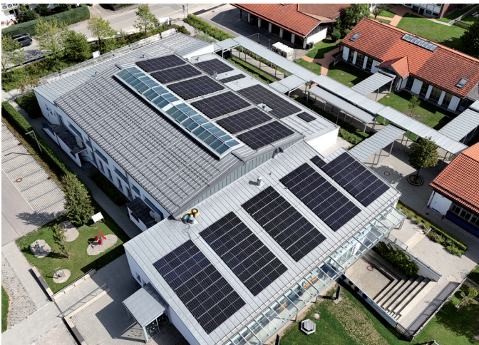
Auch auf dem Dach des Bürgerhauses wurden PV-Anlagen installiert. Die West seite des Daches wird in den nächsten Tagen bestückt.
