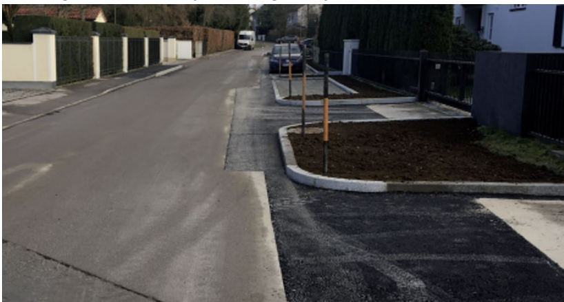
Abbildung 23 Nach der Baumaßnahme (eigene Aufnahme)
