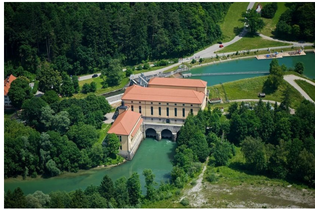
Abbildung 5 Luftbild des Mühlthalkraftwerkes (Uniper1 2023)
